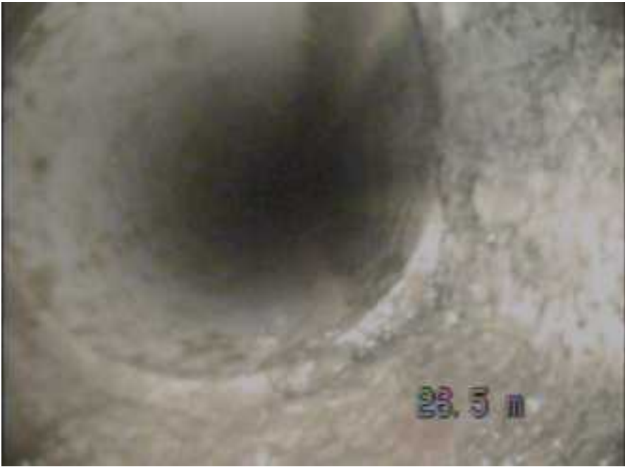
104号室汚水柵と塩ビ管との接続部 異常なし
