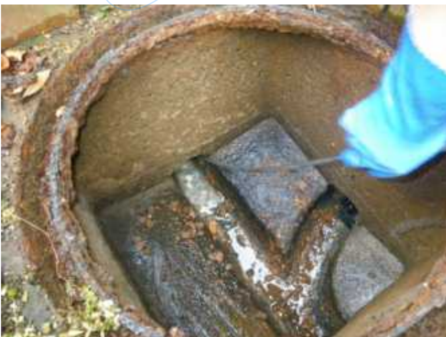
104号室汚水枡より上流側に内 視鏡投入
