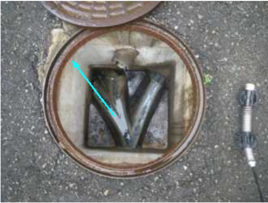
汚水柵より内視鏡投入 (矢印方向へ)
