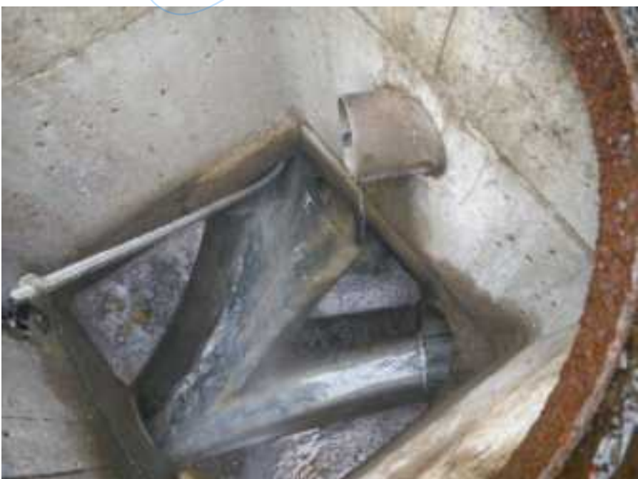
同上 汚水排出後
