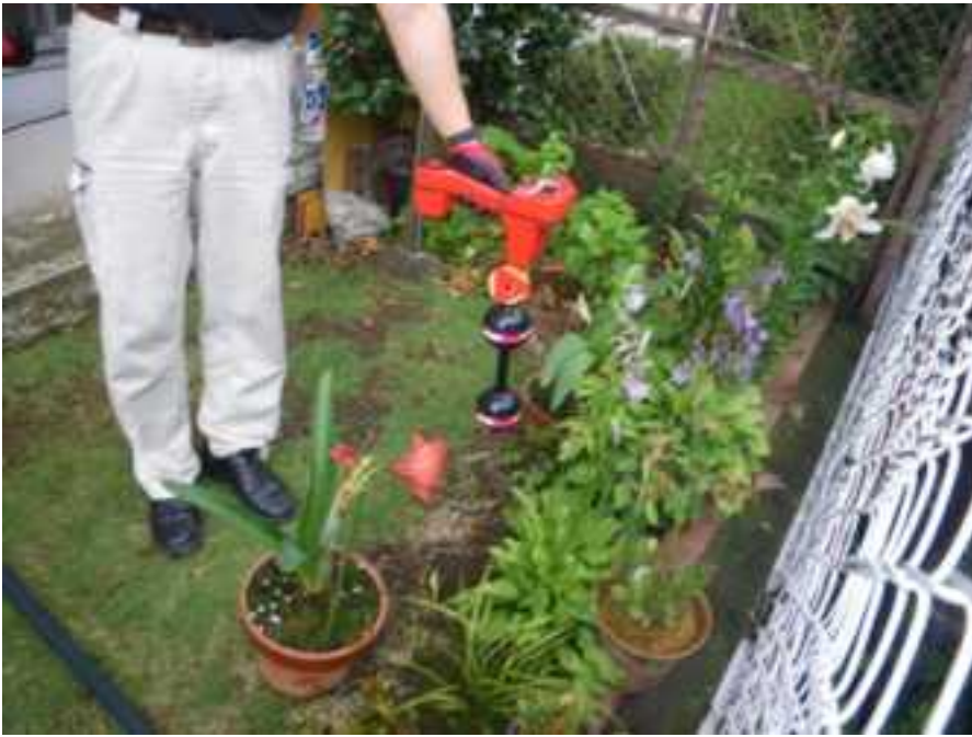
104号室専有庭内 埋設管勾配不良箇所管路調査
