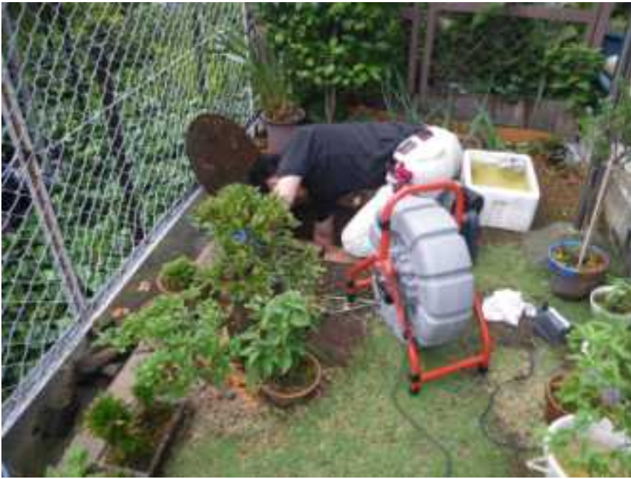
104号室専有庭内汚水枡より 改めて内視鏡投入
