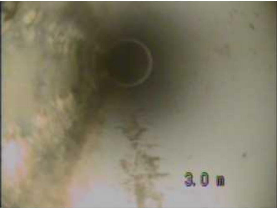
105号室汚水柵より上流配管
