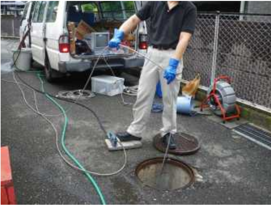
埋設汚水管 高圧洗浄
