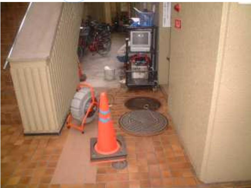
外部柵廻り埋設排水管内視鏡調査の様子
