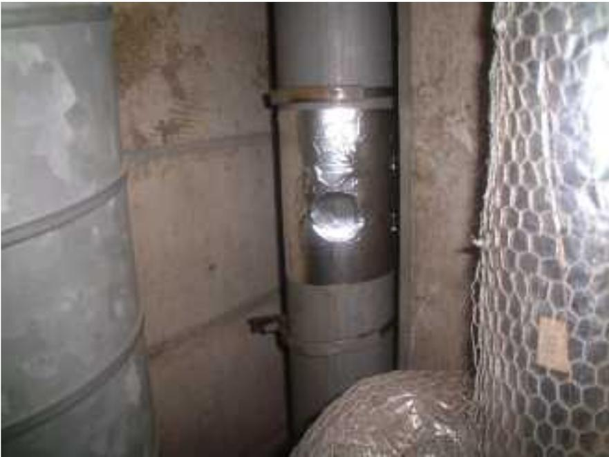
汚水立管の内視鏡を挿入した掃除口は、アルミテープで補修
